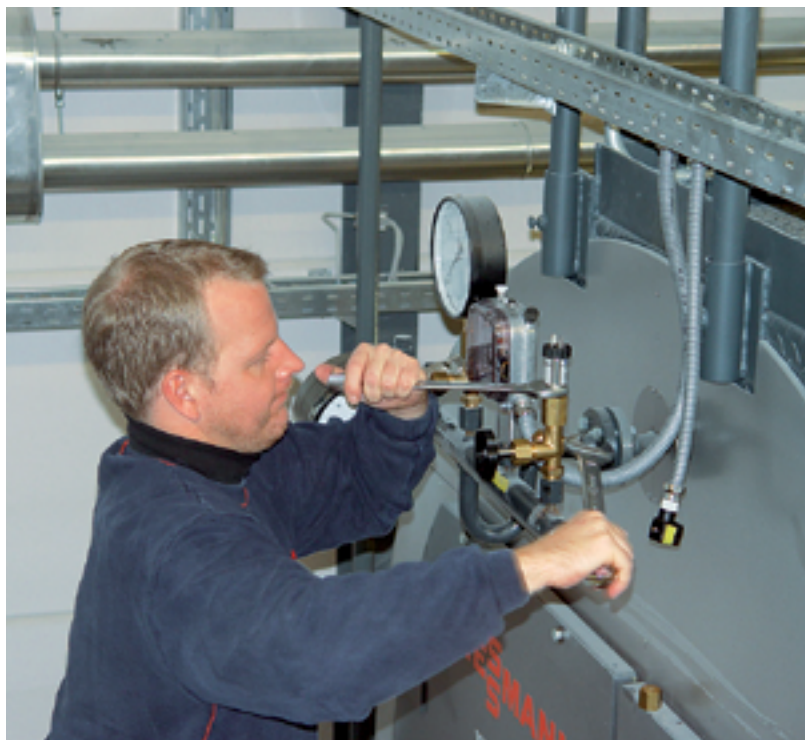
Technicien effectuant l'entretien
