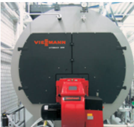
Vitamax 200-HS avec 10 t/h, 13 bars Laiterie Emmi à Lucerne, Suisse
