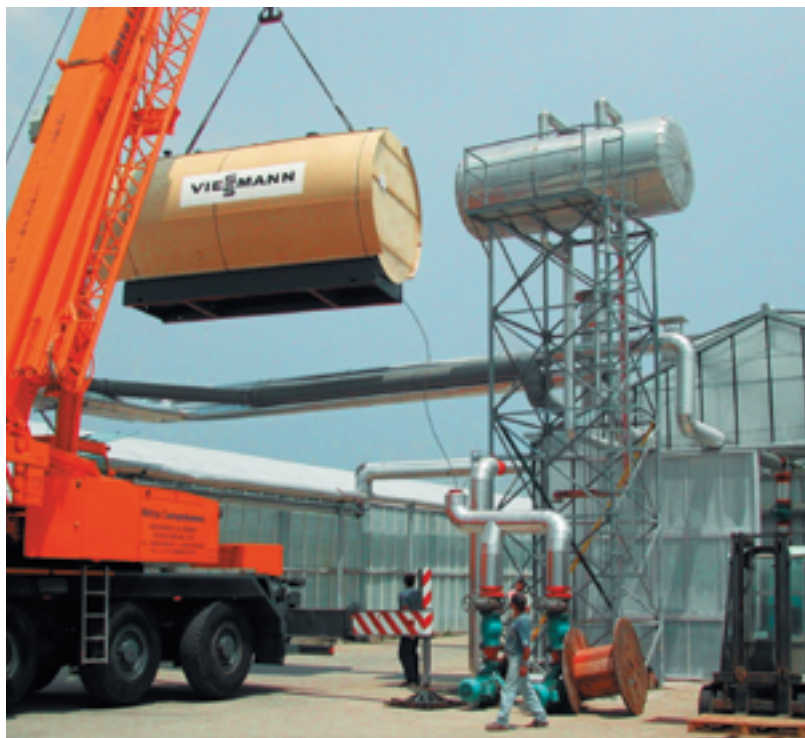
Mise en place de la Vitomax avec un camion-grue
