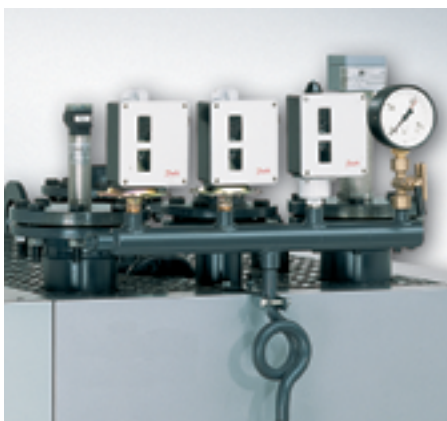
Dispositifs de sécurité de la Vitoplex 100-LS
