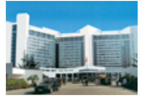
Chaudière à vapeur au General Hospital of the Peoples Liberation Army à Pékin, Chine
