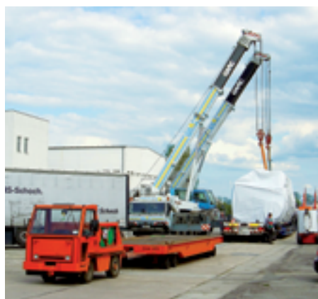
Transport d'une chaudière Vitomax
