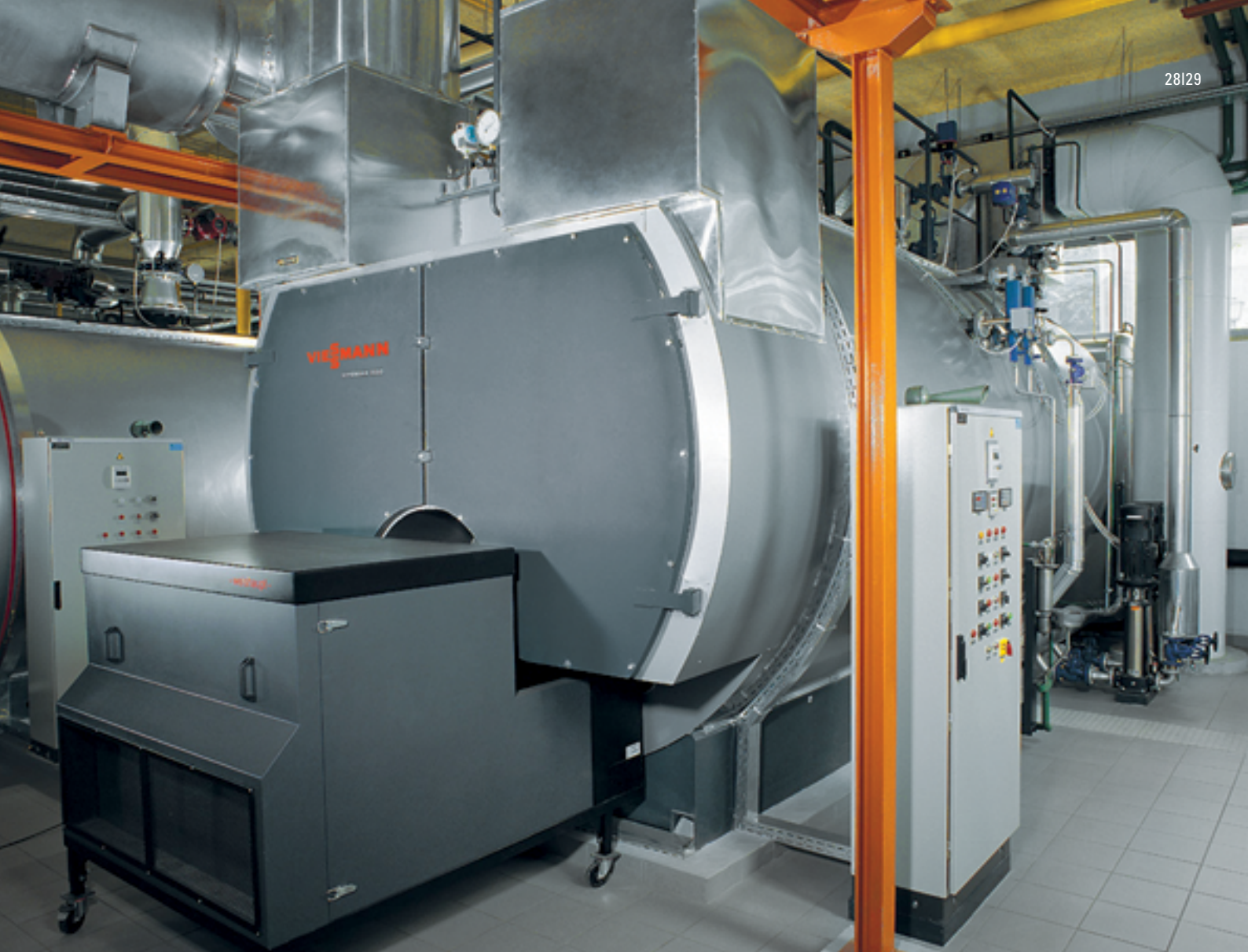
Chaudière à vapeur Vitomax 200-RS avec récupération de chaleur dans l'hôpital de Maribor, Slovénie (6 t/h, 13 bars de vapeur saturée)
