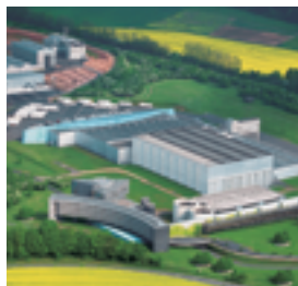
Pharmawerk L.I.F.E. B. Braun Melsungen AG : deux chaudières vapeur haute pression Vitomax 200-HS fournissent jusqu'à 40 t/h pour la production de solutions pour perfusion
